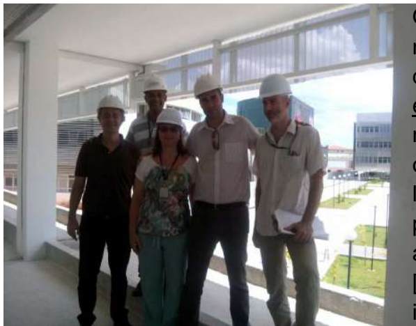
Visita à obra, junto com a nova Direção eleita e fiscais da obra.
