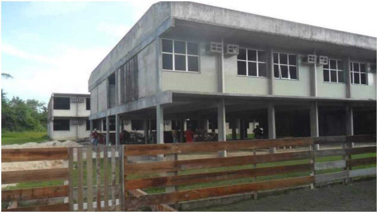
26/32 Foto do início do mês de junho mostra a situação das obras do campus de Benjamin Constant da Universidade Federal do Amazonas (Ufam). Construção foi iniciada em 2008 e até hoje não foi concluída ( Reprodução/VEJA/VEJA )
